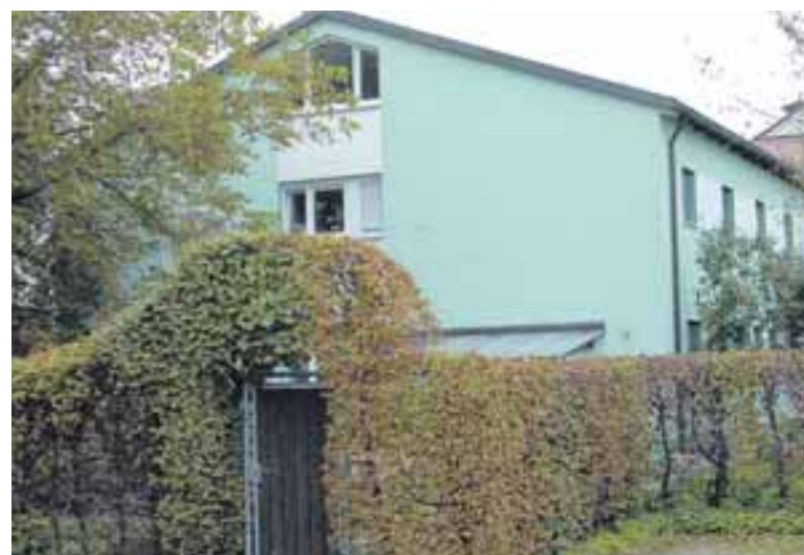
Aus dem Benild-Haus wird bald eine Hospizstation unter dem alten Namen. Das Haus befindet sich in Besitz des Kollegs der Schulbrüder.
